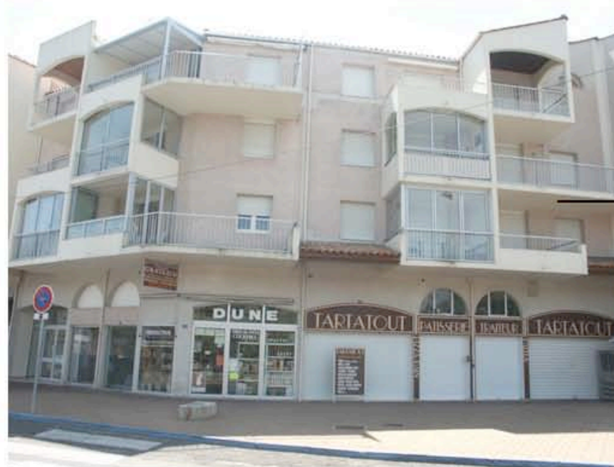
CONSTRUCTION NEUVE MAL INTÉGRÉE
